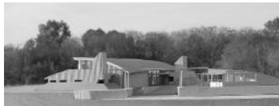
Figura 2 - Vista desde el SO, la fachada oeste, con limitadas aberturas y la fachada sur incorpora elementos de protección de los vientos fríos
