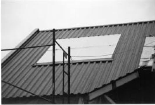
Figura 17 - Colectores solares planos para el calentamiento de agua y fotovoltaicos para generación de energía eléctrica en el techo de la vivienda
