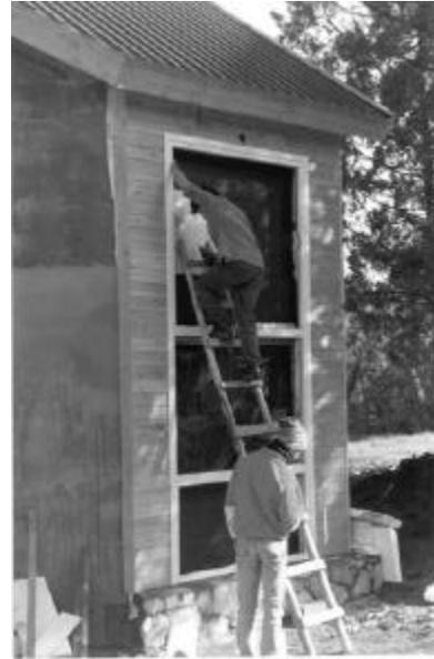
Figura 20 - Muro acumulador con ventana orientada al sol en la fachada N de la vivienda
