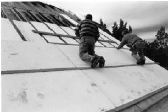
Figura 19 - Colocación de la segunda capa de aislación en el techo de la vivienda solar, sin puentes térmicos. Espesor: 20 cm (15 cm+5 cm)
