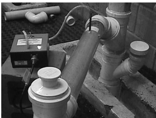
(a) Entrada do tubo de queda
