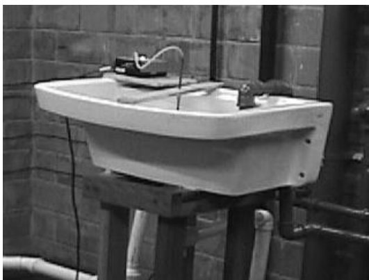
(c) F. H. do tanque de lavagem de roupas
