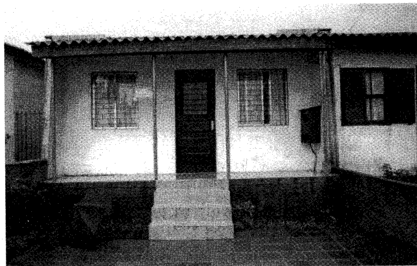
Foto 5 - Casas em fita - Costa e Silva [adição de varanda, substituição das janelas originais, melhoria do acesso frontal; casa original ao lado direito]
