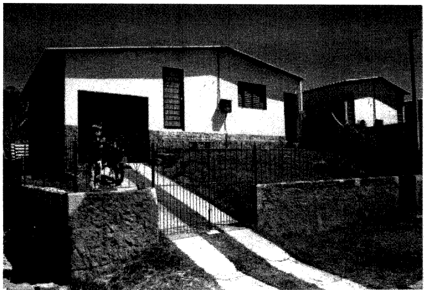
Foto 1 - Casas isoladas no terreno - Tancredo Neves [extensões laterais - garagem e acesso secundário, substituição das janelas originais, porta principal na fachada principal, melhoria do acesso frontal; casa original ao lado direito].
