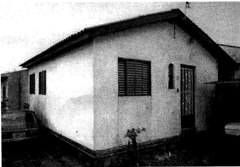
Foto 4 - Casas isoladas no terreno - Costa e Silva [substituição das janelas e modificação da posição da porta principal]
