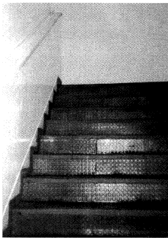
Foto 5 - Escada com revestimento anti-derrapante.
