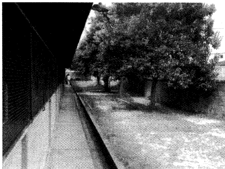
Foto 6 - Caixilhos com elementos protetores.
