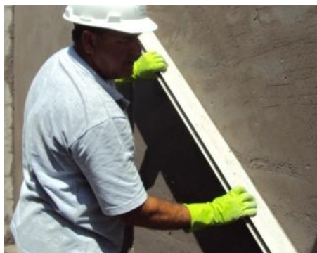
Figura 7 - Raspagem com régua H: remoção do excesso de argamassa por raspagem da superfície
