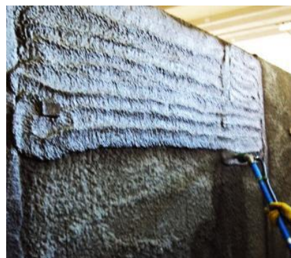
Figura 16 - Argamassa aplicada em duas demãos
