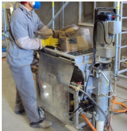
Figura 10 - Equipamento de mistura e projeção de argamassa utilizado
