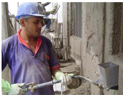
Figura 2 - Projeção por spray a ar comprimido
