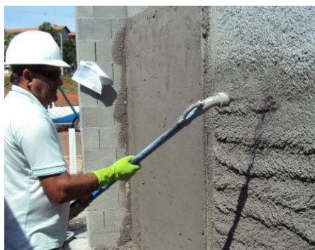
Figura 19 - Aplicação com projeção mecânica
