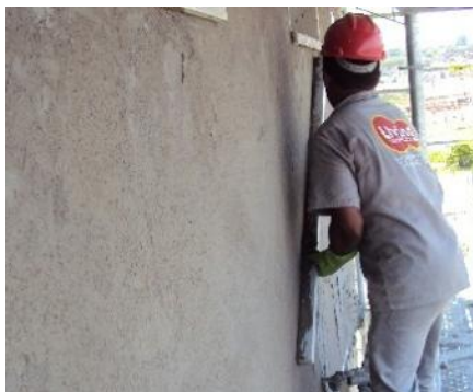
Figura 6 - Sarrafeamento tradicional: corte do excesso de argamassa com régua retangular
