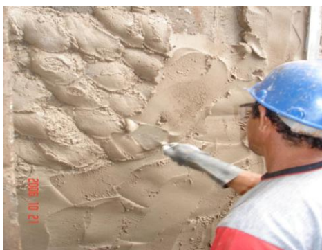
Figura 4 - Compressão da argamassa com o dorso da colher de pedreiro após lançamento manual
