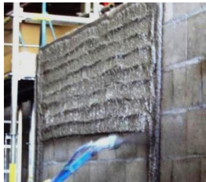
Figura 15 - Argamassa aplicada em uma demão
