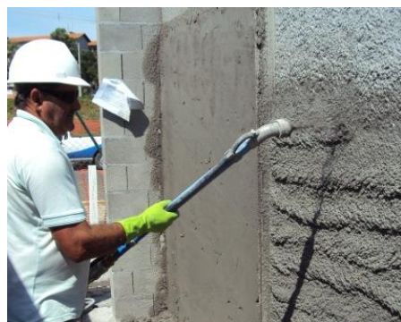
Figura 2 - Projeção por spray a ar comprimido
