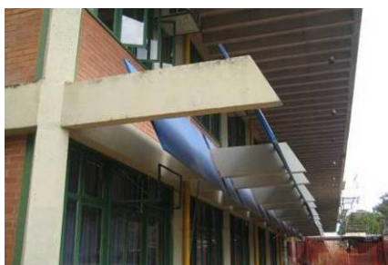
Figura 7 - Brises soleil na fachada norte da FAV
