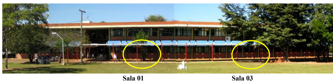
Figura 15 - Panorâmica da fachada norte do edifício da FAV, em 26/06/2009, às 12 horas - Solstício de inverno
