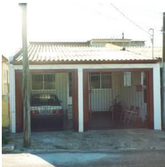
Figura 5 - Garagens construídas em frente às casas em fita prejudicando o conforto lumínico da moradia - Costa e Silva
