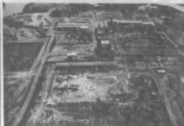
Outra vista aérea da usina de polioacetato, podendo-se observar, à esquerda, os tanques de decantação.
