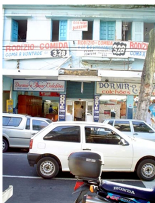
Fig. 5. Centro deteriorado: poluição visual na rua Marechal Deodoro, 14,82 x 11,11cm.
