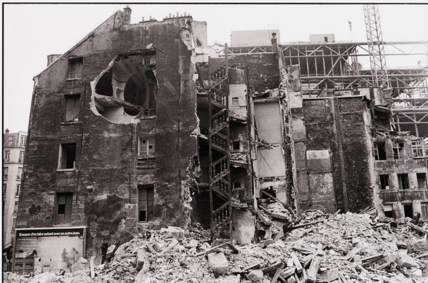
Figura 6. Gordon Matta-Clark. Vista da demolição da obra Conical Intersect , 1975. Fotografia, 26,9 x 39,9 cm, Paris, França. Fonte: https://www.cca.qc.ca/en/search/details/collection/object/477507 .
