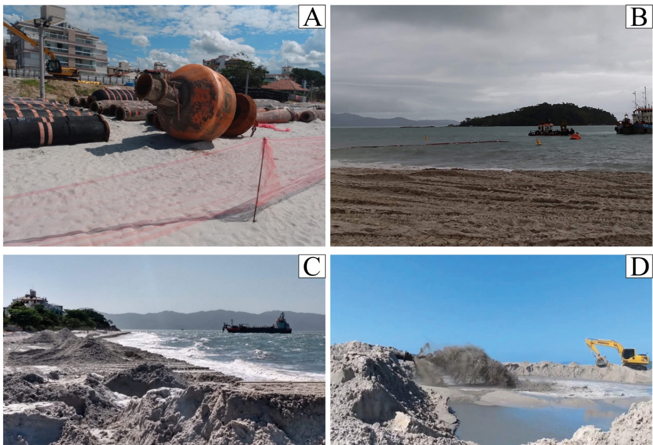
Figura 4. A) Tubulação utilizada para conduzir o sedimento da cisterna da draga até a praia. B) Draga sendo acoplada a tubulação. C) Sedimento depositado na praia, com a draga em segundo plano. Após concluir a operação na área da jazida, a draga se desloca até a proximidade da linha de costa e se conecta a uma rede de tubulação para dispor o material na praia. D) AAP sendo realizada na praia de Canasvieiras. Se observa o bombeamento dos sedimentos através da rede de tubulação, enquanto o maquinário os espalha. Fotografias do autor.
