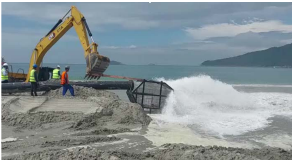
Figura 11. Praia dos Ingleses. Observa-se o dispositivo (gaiola) na saída da tubulação utilizado para reter o material carbonático que apresentava granulometria inadequada. Nas inspeções iniciais realizadas pelo IMA durante o início das obras, verificou-se que havia um volume mínimo de conchas, o que tornou desnecessário o uso do dispositivo. Fotografia do autor.
