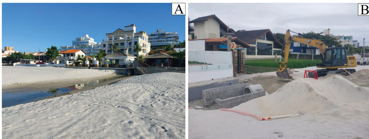
Figura 13. A) Canais de drenagens pluviais após as obras na praia dos Ingleses; B) Devido ao acúmulo de água na praia, situado na retaguarda da elevação topográfica construída, foram reduzidas o número de drenagens que desaguam na praia e dispositivos complementares foram instalados. Fotografias do autor.
