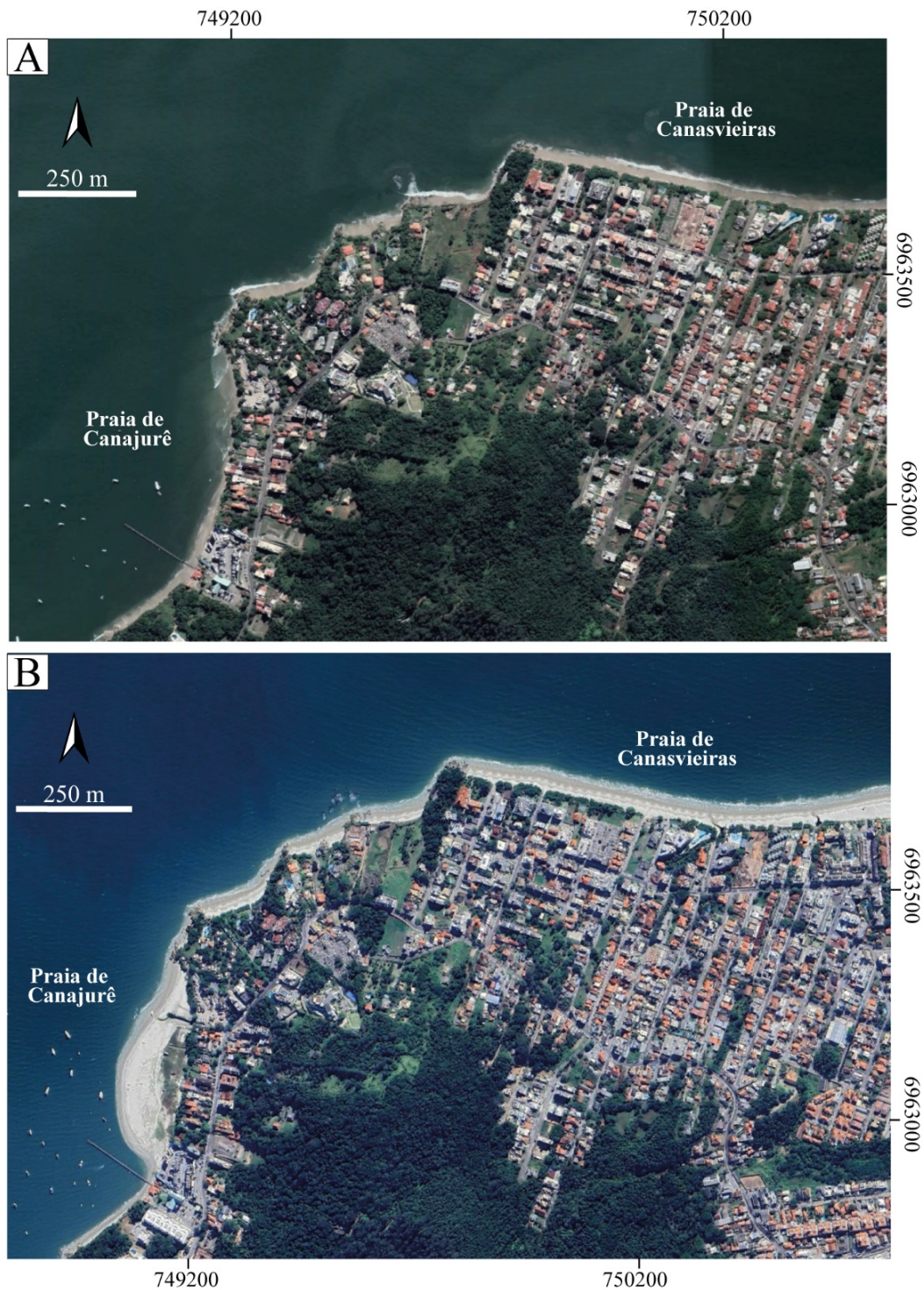
Figura 7. A) Imagem do satélite Google Earth Pro (2018) anterior a AAP. B) Imagem do satélite Google Earth Pro (2023), cerca de três anos e meio após a conclusão das obras. Nessa imagem, é possível observar um notável acúmulo de sedimentos provenientes provavelmente do processo de engordamento da praia de Canasvieiras, os quais foram transportados no sentido oeste, seguindo a direção da deriva litorânea (leste para oeste). Esses sedimentos contribuíram para a formação de uma projeção na praia de Canajuré. Ao sul dessa projeção, é visível a presença do trapiche pertencente a uma marina.
