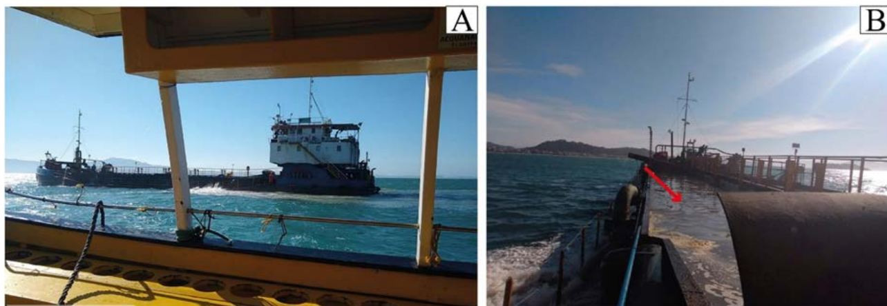
Figura 3. A) Em segundo plano se observa a draga em operação na jazida que foi utilizada para AAP em Canasvieiras. B) Seta vermelha onde se evidencia a cisterna, uma espécie de porão de carga onde uma mistura de água e sedimentos é armazenada para posterior deposição na praia. Fotografias do autor.
