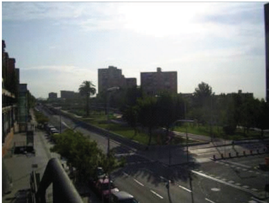
Figura 10 - Vista de cima da Ronda de Dalt: conexão entre autopistas, calçadas, ciclovias, parques lineares, praças
