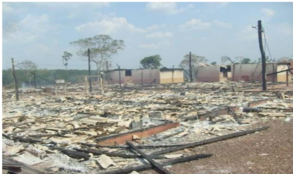
Figura 2. Enawenê-nawê incendiaram o canteiro de obras da Pequena Central Hidrelétrica Telegráfica, na cidade de Sapezal, MT
