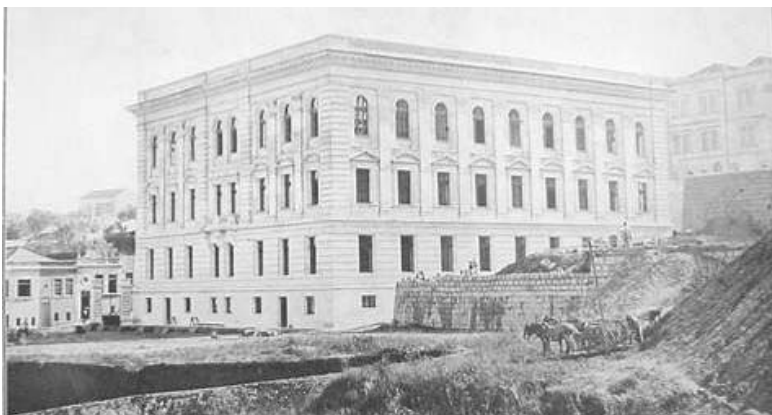
Fotografia 2. Escola Complementar, para 2000 alunos, em Porto Alegre (título original). Projeto da secretaria de Obras Públicas (legenda original). Fonte: ESTADO DO RIO GRANDE DO SUL. [Secretaria de Obras Públicas]. Obras públicas: centenário da Independência . Porto Alegre: Oficinas Graphicas d'A Federação, 1922. Acervo: Arquivo Histórico do Rio Grande do Sul
