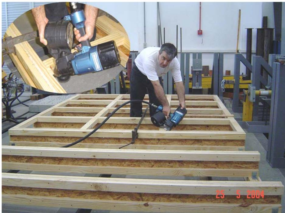
Figura 5 - Fixação dos elementos enrijecedores nas vigas-I
