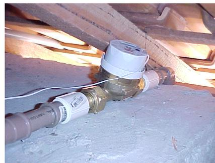
**Figura 4** - Detalhe da instalação do hidrômetro eletrônico para a medição do consumo geral da residência (OLIVEIRA JÚNIOR, 2002)
