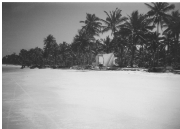
Figura 8 - Destruição de edificações na praia do Norte (Ver figura 3 para localização).
