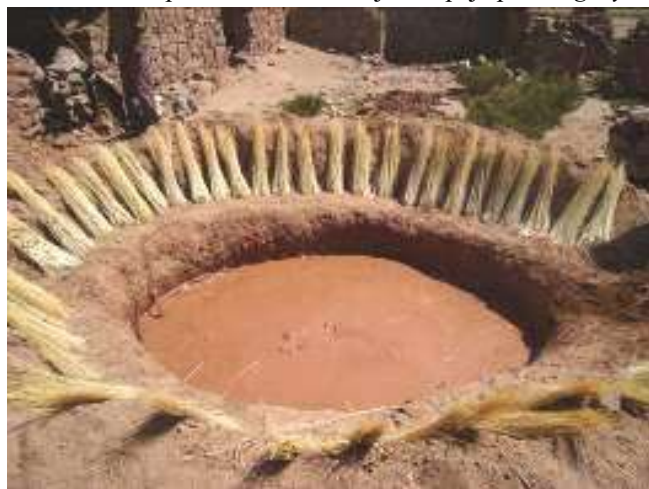
Figura 7 – Pozo de barro para embeber manojos de paja para el guayado del techo
