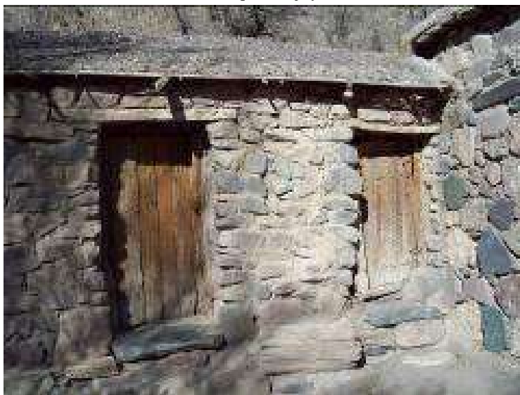
Figura 10 – Fachada de una casa, realizado con piedra y junta de tierra, en la comunidad de Susques, Jujuy
