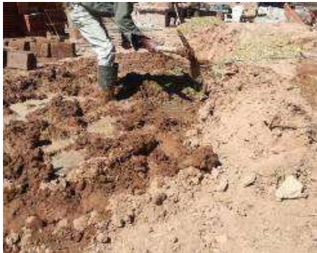
Figura 6 – Batido del barro para la fabricación de adobes
